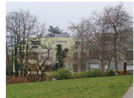
Tree Houses on Susenbergstrasse, Zurich 9 logements répartis en 3 immeubles Annette Gigon / Mike Guyer pour Grünberg Baugesellschaft
