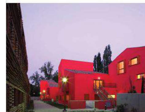
Terre neuve à Villefranche sur Saône 30 logements intermédiaires et individuels sociaux Petitdidier Prioux Architectes pour HBVS
