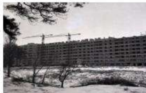
Construction de la barre des cygnes en 1960
