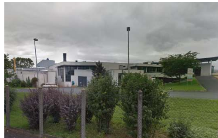
Station de traitement des eaux usées de Villefranche-sur-Saône // Google Maps
