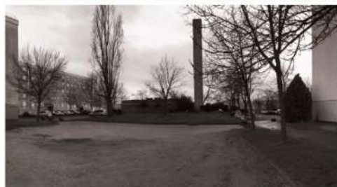
UN ESPACE DELAISSÉ AU PIED DE LA CHAUFFERIE QUI DEGRADE L'IMAGÉ DES RÉSIDENCES
