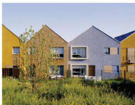
Vert Saint Denis, 77 19 logements individuels sociaux Po&Po pour Foyers de Seine-et-Marne
