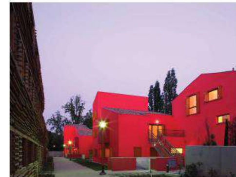
Terre neuve à Villefranche sur Saône 30 logements intermédiaires et individuels sociaux Petitdidier Prioux Architectes pour HBVS
