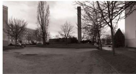
UN ESPACE DELAISSÉ AU PIED DE LA CHAUFFERIE QUI DEGRADE L'IMAGÉ DES RÉSIDENCES
