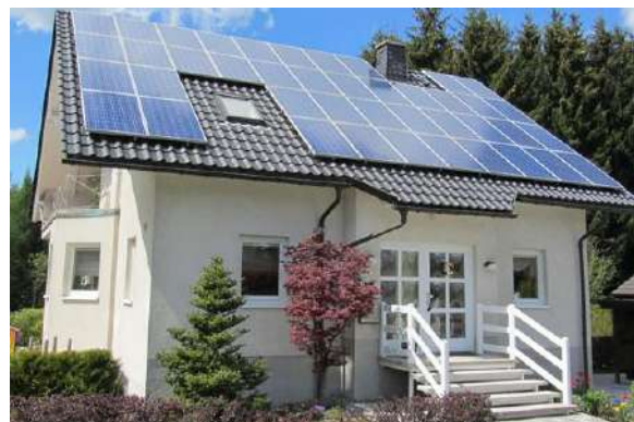
Couche mince CIS // Maison&Travaux
