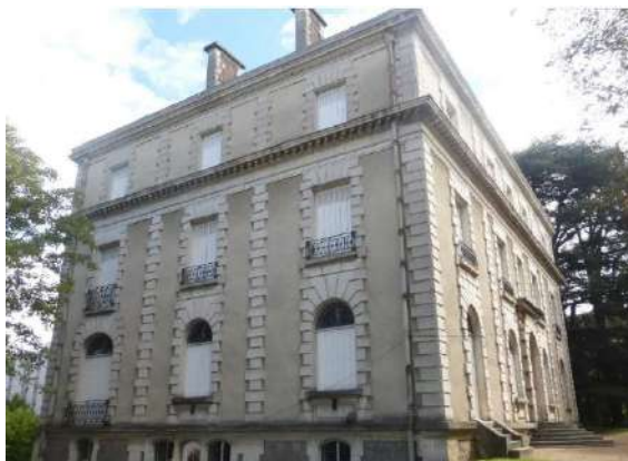
Façades sud et est de la Villa Vermorel // Dossier d'élaboration de PDA CAVBS
