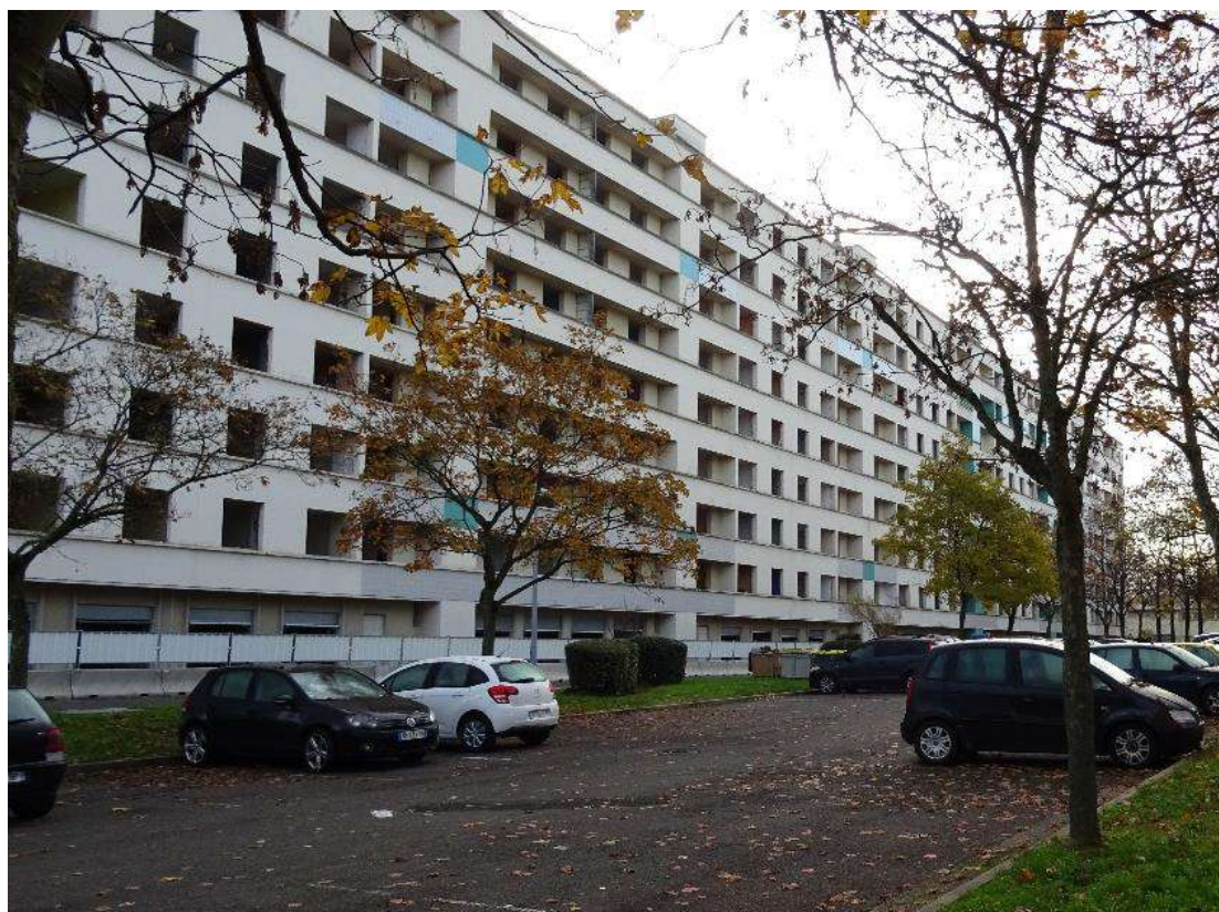
Nappes de stationnement en pied d'immeuble et absence de connexions « attractives » avec les cœurs d'îlots // Even Conseil
