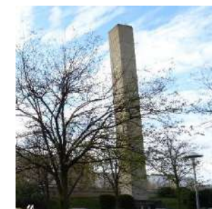
Dispositifs solaires sur toiture et tour de la chaufferie dans le quartier de Belleroche // Even Conseil
