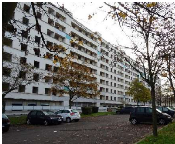
Bâti et espace imperméabilisé // Even Conseil
