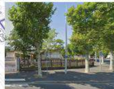
Le groupe scolaire Jean Bonthoux qui tourne le dos à la rue Belleroche
