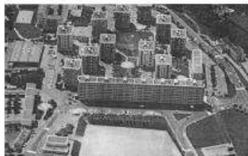
La construction de Belleroc'hé ouest
