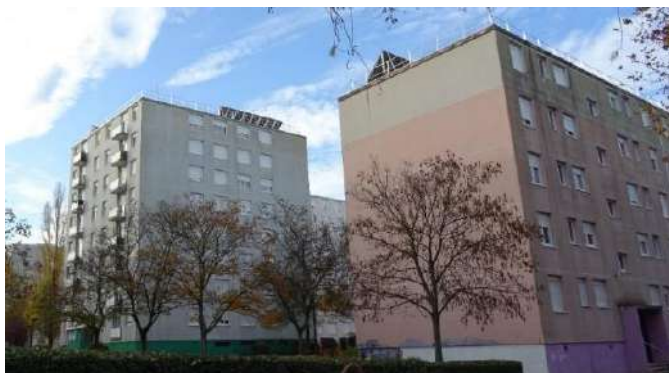
Panneaux solaires thermiques sur les toitures des bâtiments du
